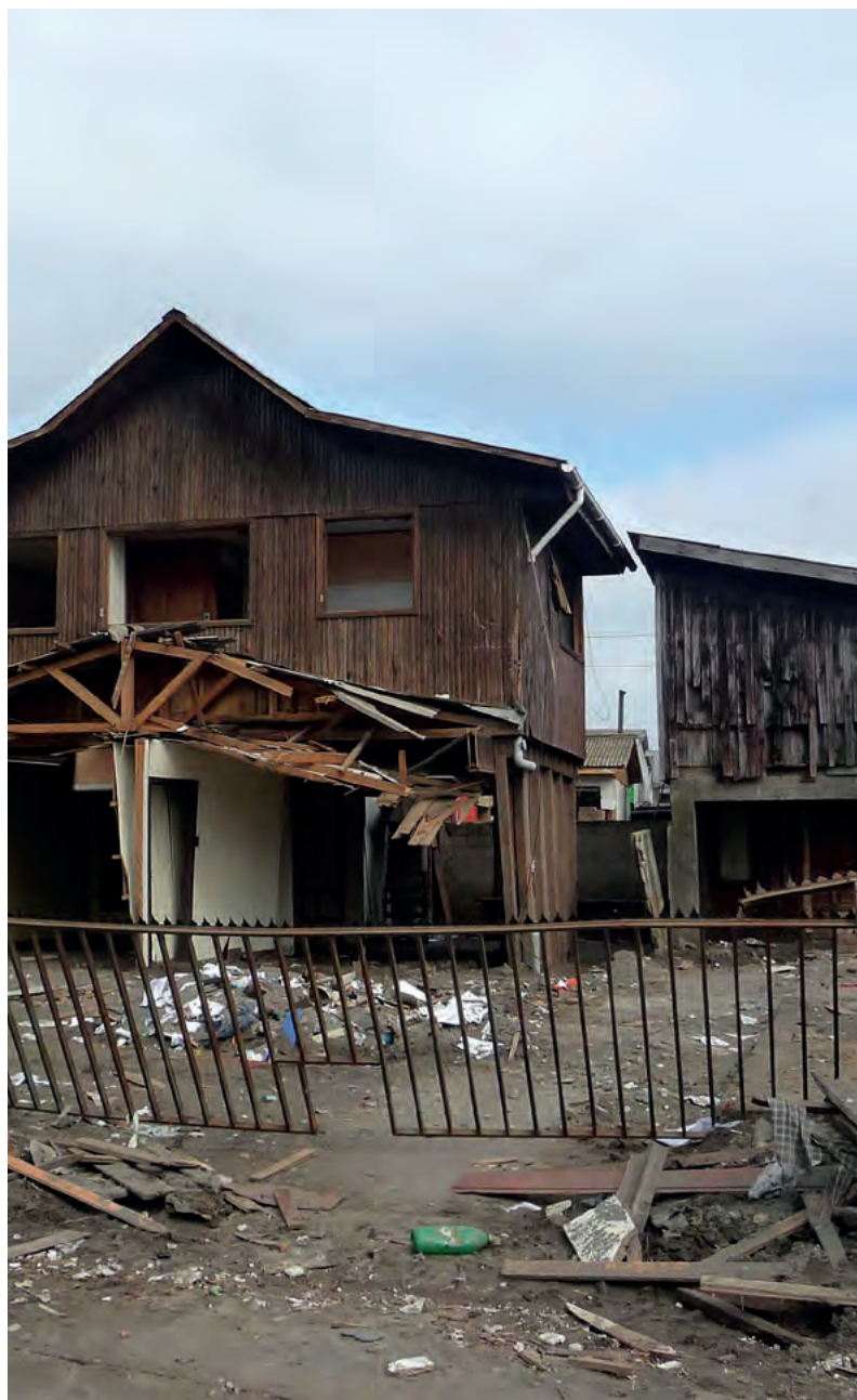
Edificios en la región Linares destruidos por el terremoto del año 2010.
